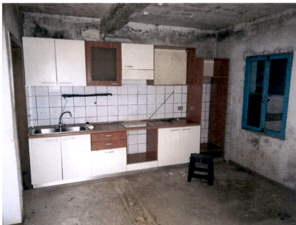
PARTICOLARE INTERNO – PRANZO/CUCINA
