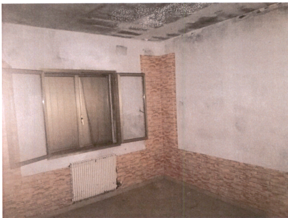
PARTICOLARE INTERNO – CAMERA PICCOLA
