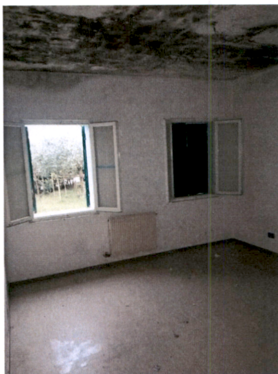
PARTICOLARE INTERNO – CAMERA GRANDE
