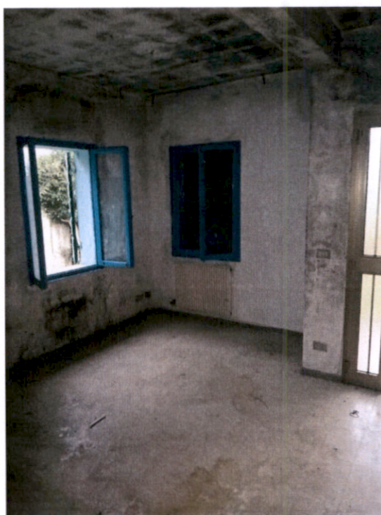
PARTICOLARE INTERNO – PRANZO/CUCINA
