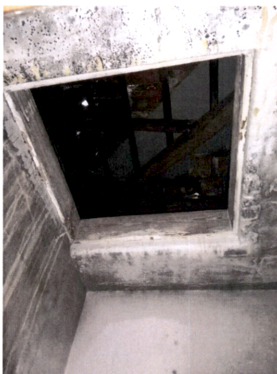
PARTICOLARE INTERNO VISTA INTERNA DELLA COPERTURA DALLA BOTOLA SUL DISIMPEGNO
